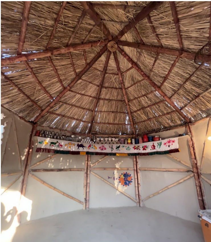
LOG (Lari OctaGreen) Hauses mit Kalkputz auf Schilfmatten von innen
