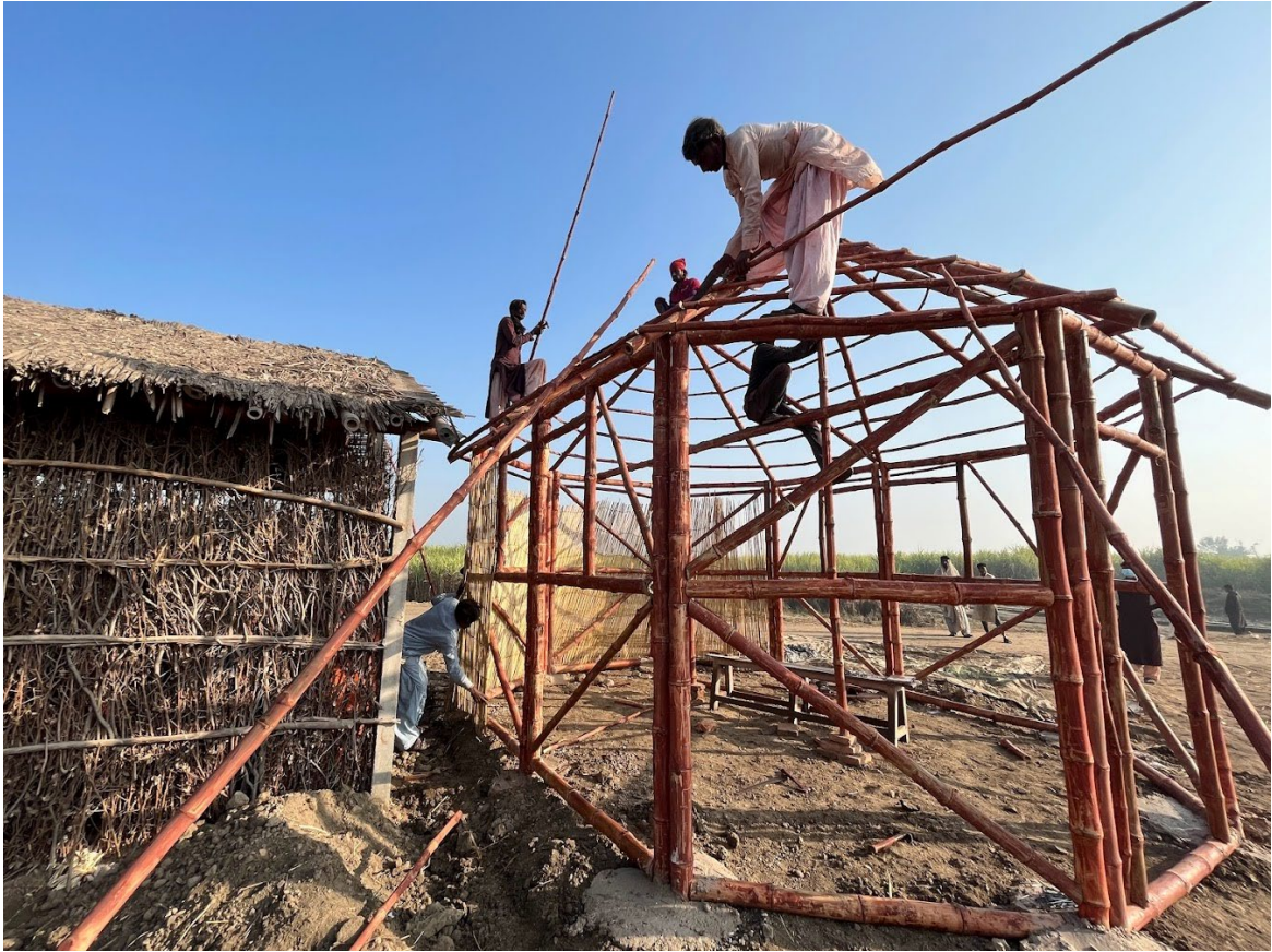
Im Bau befindliches LOG (Lari OctaGreen) Haus aus vorgefertigten Bambusrahmen mit Kalkfundamenten und Schilfmatten als Wandkonstruktion
