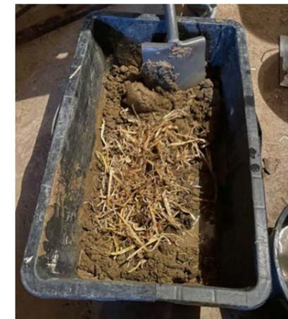
Abb. 05: Vermengen von Lehm, Sand, Wasser und anschließend Stroh
