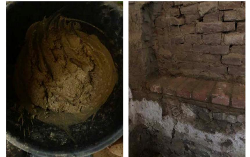
Abb. 20-21: Mörtelmischung für Stoßfugen
