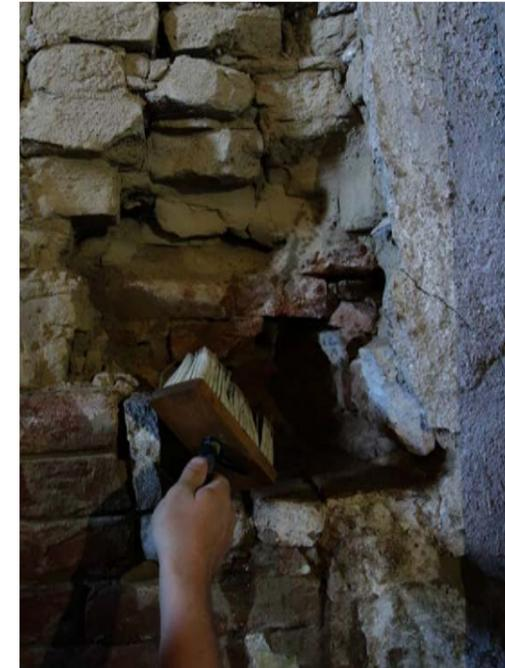
Abb. 11: Befeuchten des Loches
