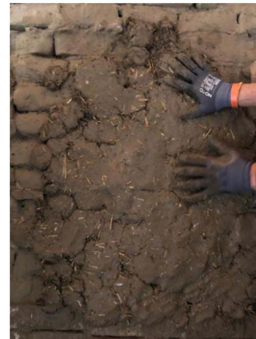
Abb. 19: Anpressen durch Händedruck
