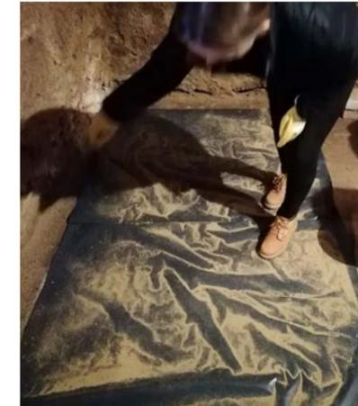
Abb. 02: Auslegen der Plastikfolie und Bestreuen mit Sand
