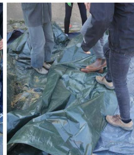
Abb. 09: Verdichten der Mischung durch Stampfen
