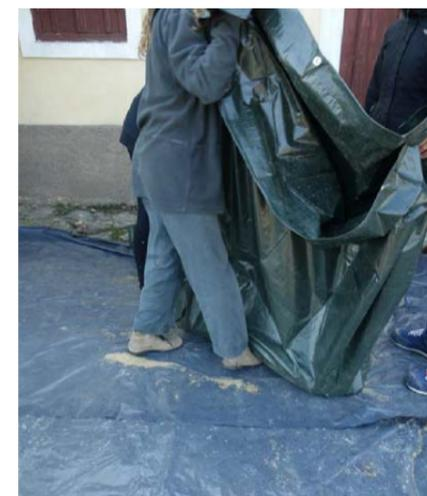
Abb. 08: Durchmengen der Mischung durch Anheben der Plane
